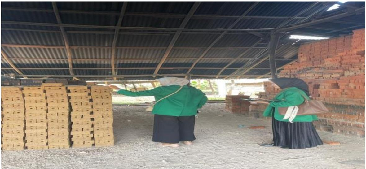
**Gambar 4.** Hasil pembuatan batu bata yang siap untuk di bakar.
