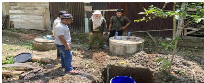
Gambar 5. Pembuatan SPAL Percontohan
